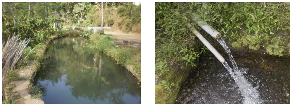
Gambar 6.2 Kondisi Sumber Air di Kecamatan Tirtoyudo
